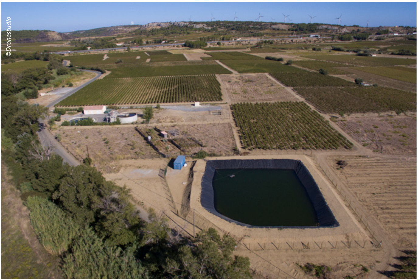
Installation REUT de Roquefort-de-Corbières (Aude), exploitée par BRL Exploitation
